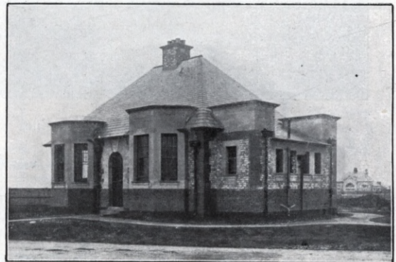
Figur 192. Ansicht des Entlassungspavillons.
