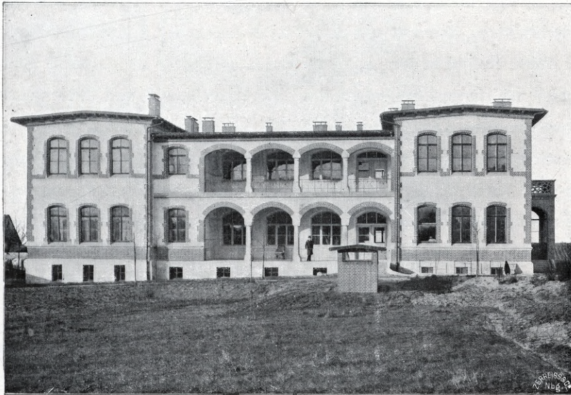
Figur 48. Krankbau Nr. 36 (Ansicht der Südseite).
