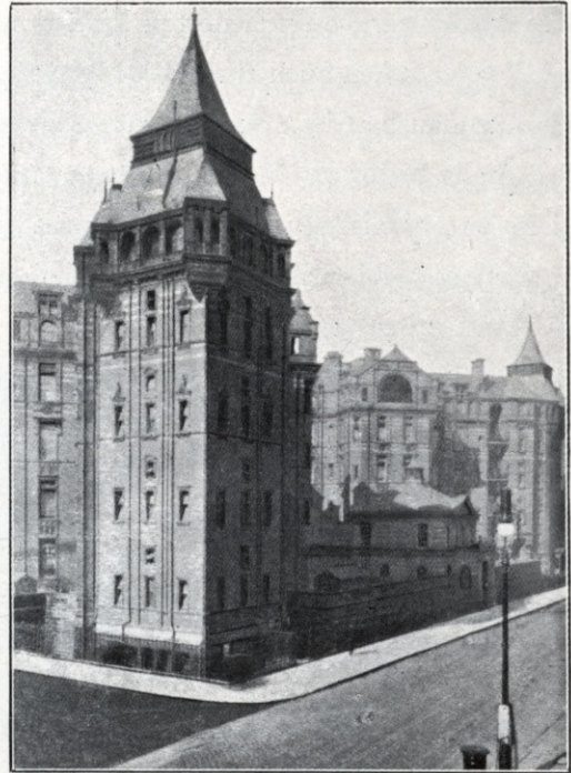
Figur 198. Teil der äusseren Ansicht.
