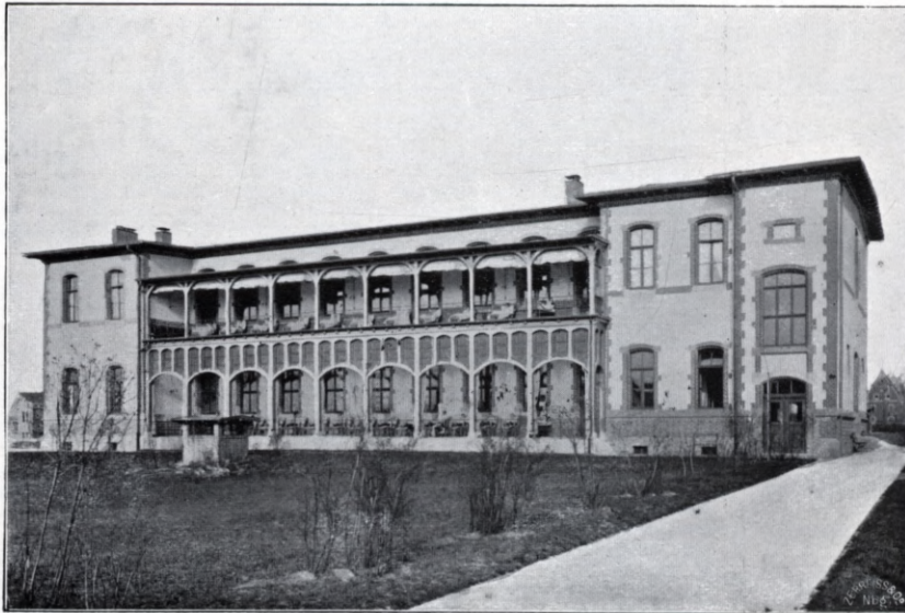
Figur 46. Krankenbau Nr. 32 (Ansicht der Westseite).
