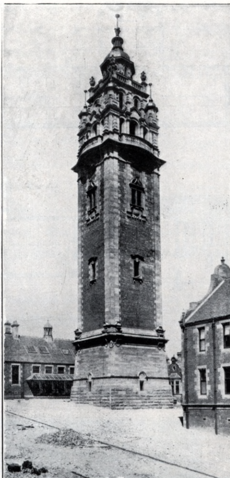
Figur 162. Ansicht des Wasserturmes.
