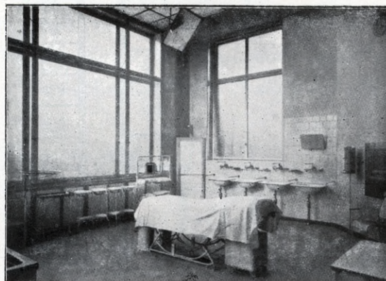
Figur 60. Innenansicht des aseptischen Operationsaales.
