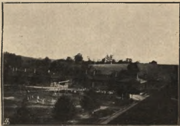
Rys. 2. Środkowa część Zakładu. Zabudowania administracyjne.
