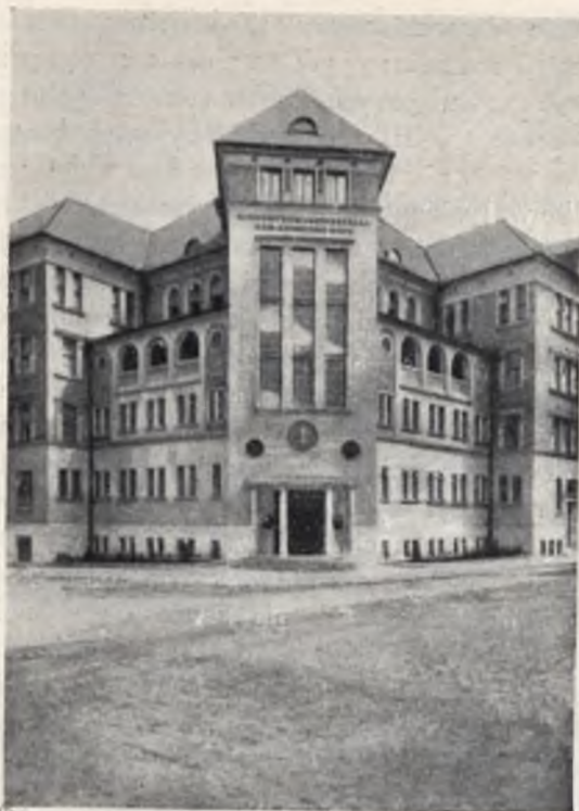
Centrala Kinderübernahmestelle, widok ogólny.
