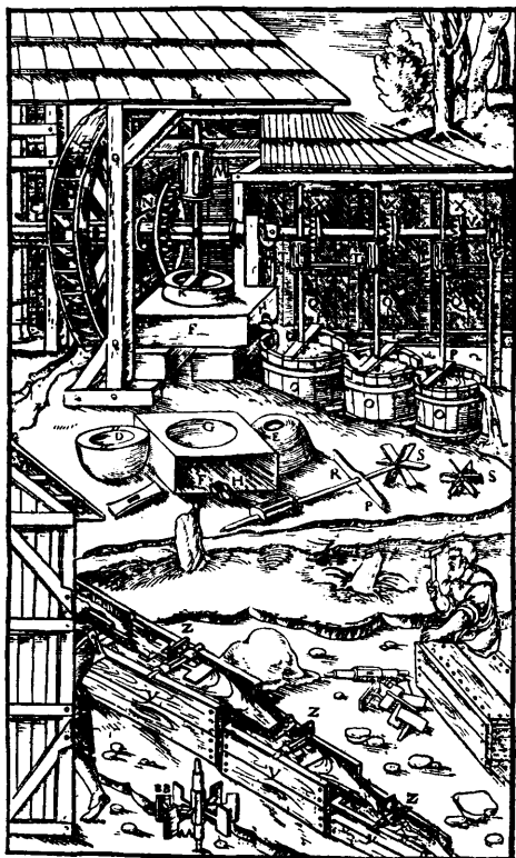
Fig. 21. Goldgewinnung mittelst Amalgamationsverfahren nach einem Holzschnitte vom Jahre 1557.
